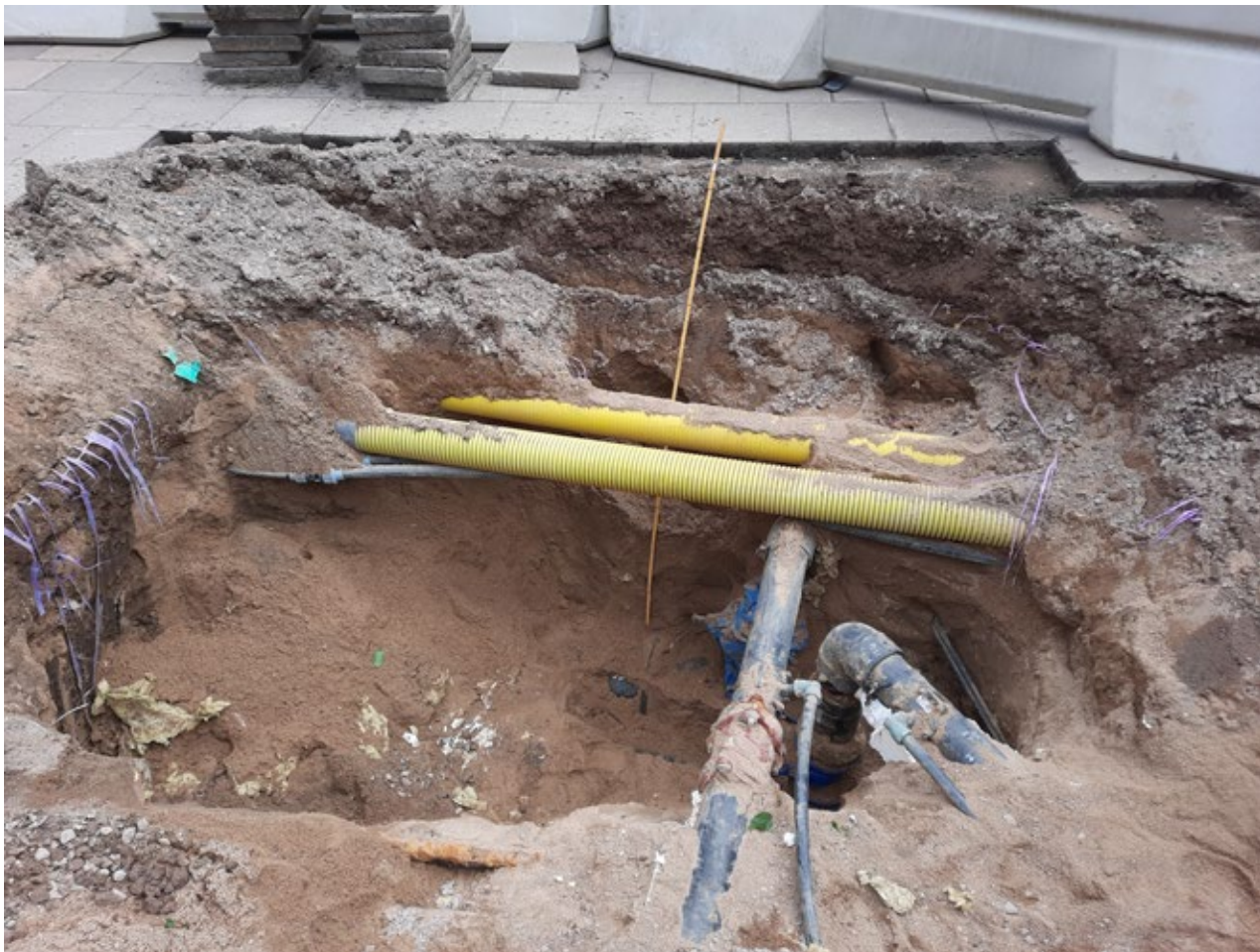
Figur 3. Schaktet då det grävts till djupet för fjärrkylan. Mot öst. Foto: Jonas Carlsson, F-nr 2024-57-01.
